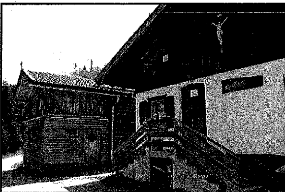
Abb. 6: Almhütte und Stallgebäude Nordseite
