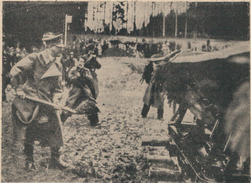
Der Führer tut den ersten Spatenstich an der neuen Reichsautobahn bei Salzburg.
